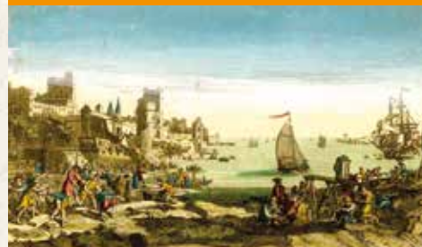
Vue du port et des chantiers civils du Havre © Archives Municipales du Havre, 5F13
